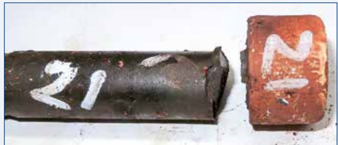
Schraubenbruch · Bolt failure
